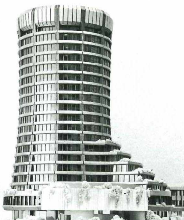
Einwandfreie Fenster- und Türrichtungen bei Bauten sind unerlässlich für wirksamen Lärmschutz und zur Energieeinsparung. Bally CTU arbeitet deshalb eng mit der Bauindustrie zusammen.
