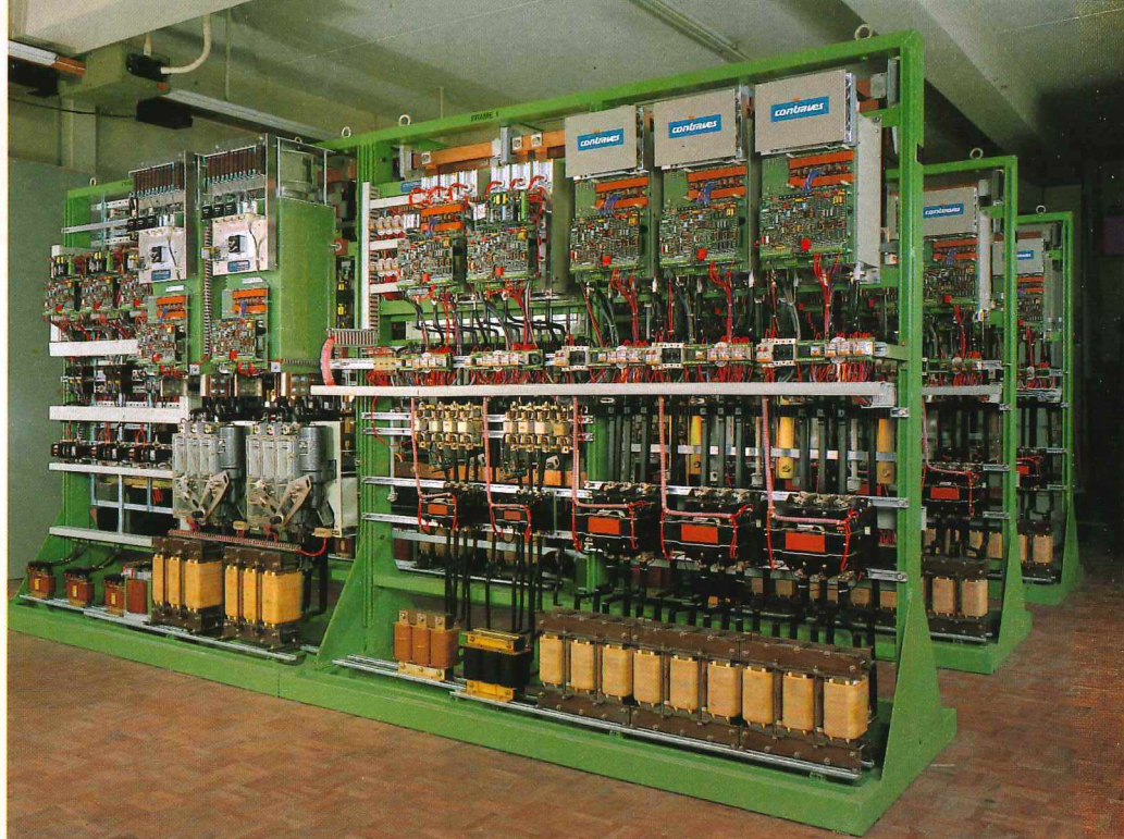
Steuerschrank zur Regelung von Kalanderantrieben von Kunststoffmaschinen.
